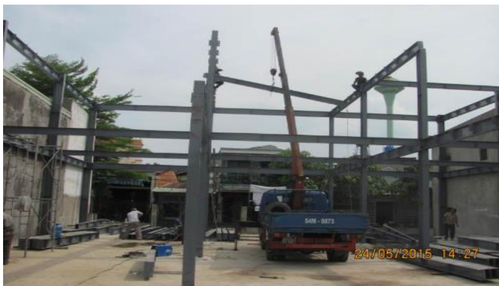
Hình 5.1. Lắp đặt kết cấu thép
