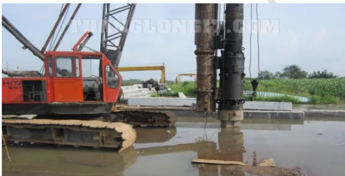
Hình 3.2. Thi công cọc đóng
