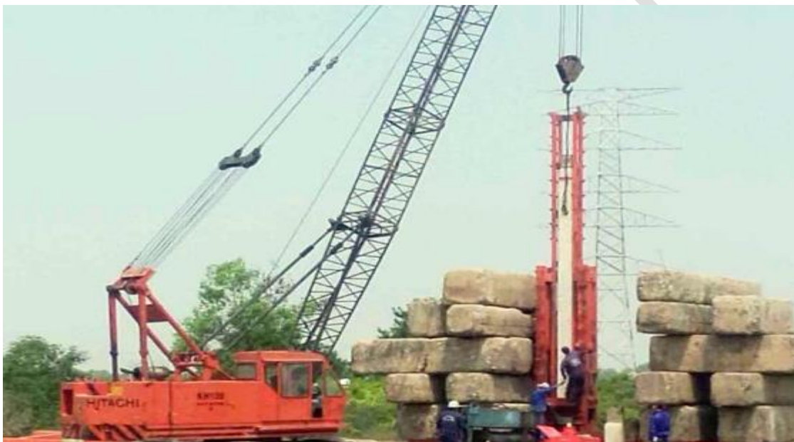
Hình 3.1. Thi công cọc ép
