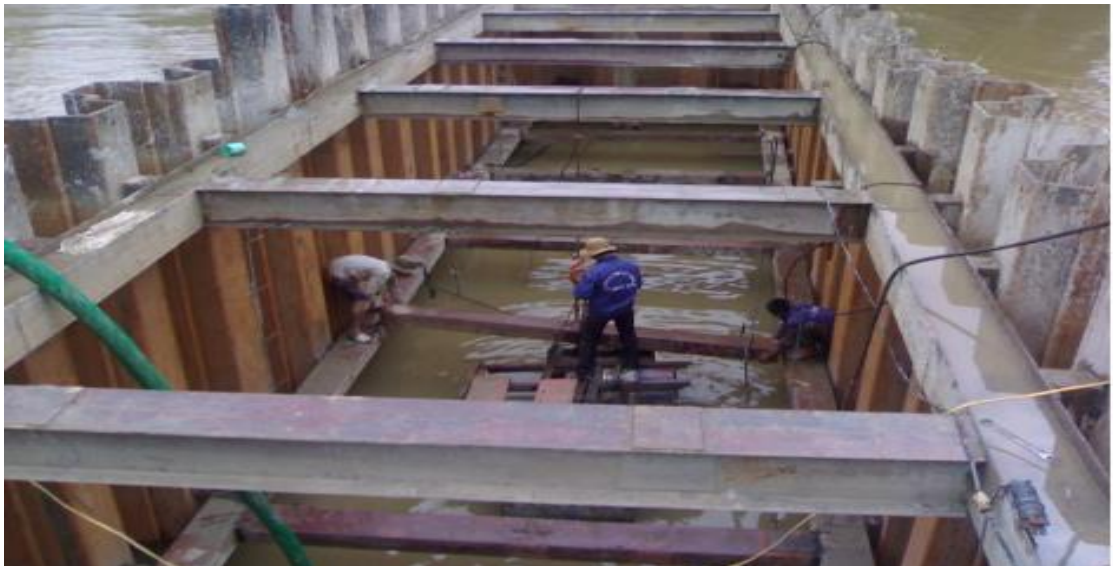
Hình 3.4. Thi công tường vây công trình
