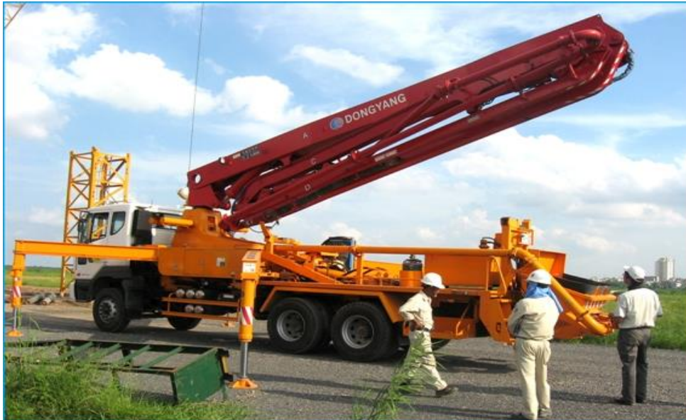
Hình 7.2. Người điều khiển hoạt động của máy bơm bê tông tự hành
